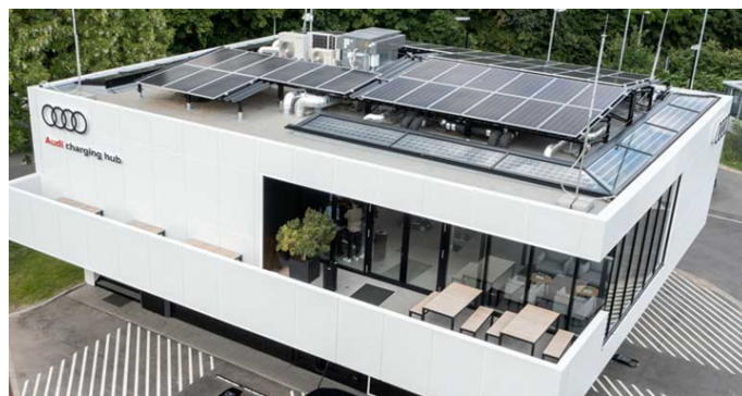
Abbildung 3-13 Projektreferenz zur PV-Überdachung technischer Anlagen (Quelle: AUDI)
